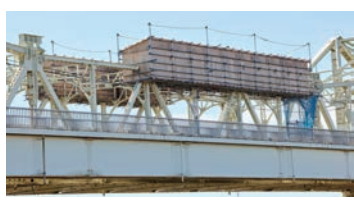
補修工事の足場
