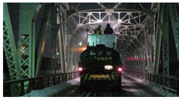
雷庇(せっぴ)処理作業
