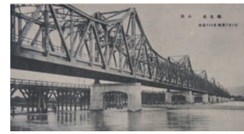
竣工時の3代目長生橋(長岡戦災資料館所蔵)
