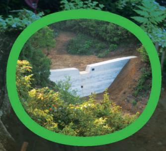
完成した谷止工
